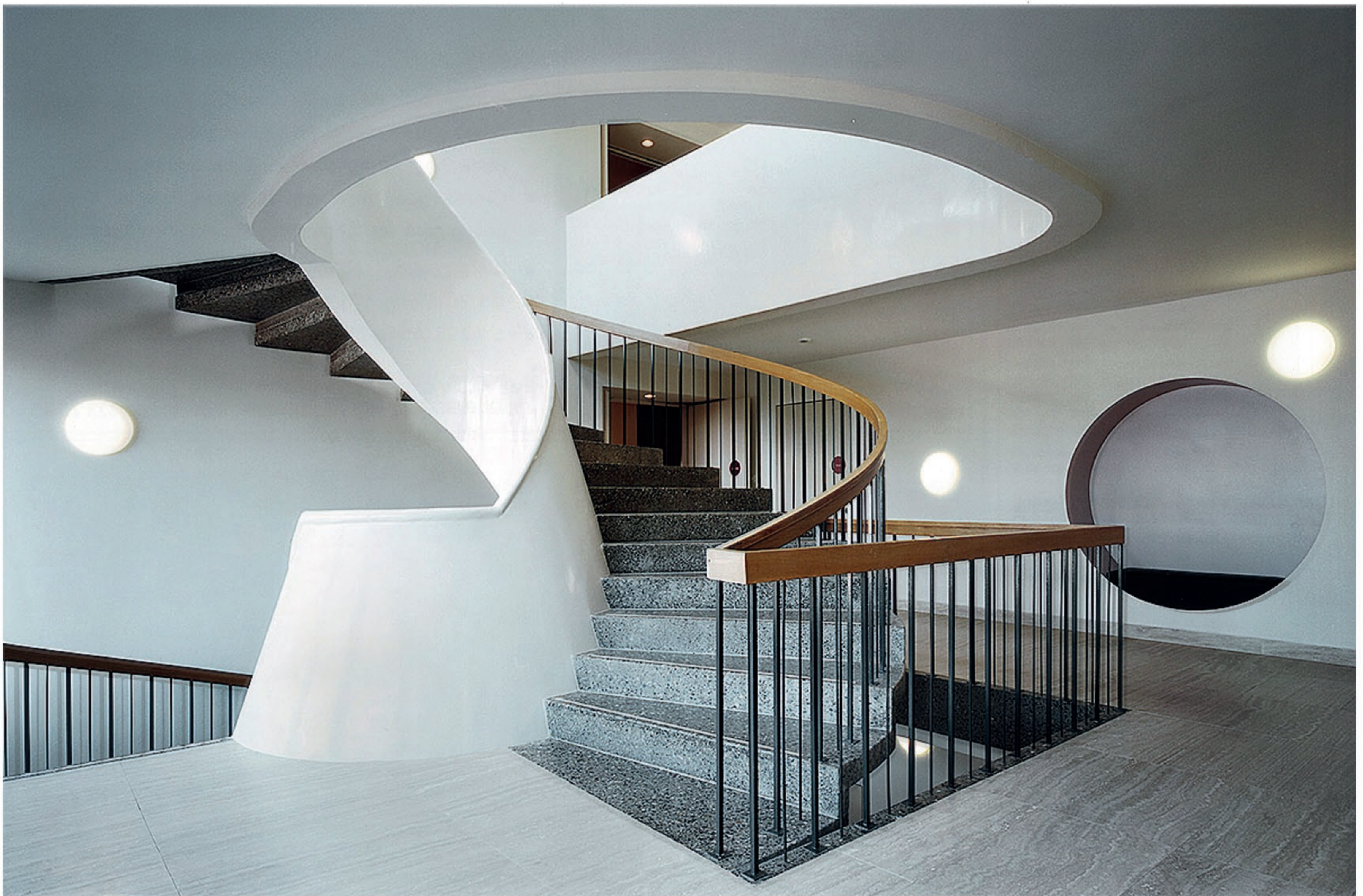
Wendeltreppe: Raumbestimmende Spiralskulptur aus Kunststein, Beton und Travertin
