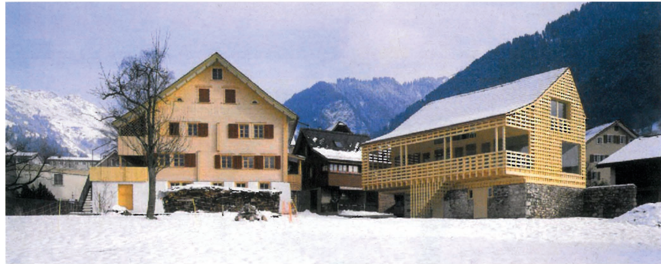
Haus- und Stallumbau, Bürglen: Strahlt in einem neuen, noch hellen Schindelkleid.
