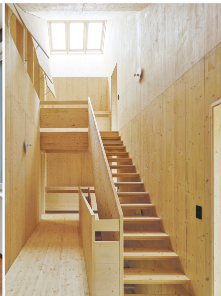
Treppenraum der Hauptwohnung: Offene Konstruktion aus Balken und Latten
