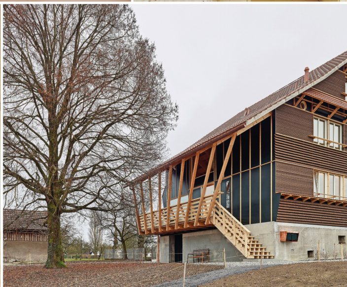
Laube mit Zugang zu den zwei kleineren Wohnungen: Schöner Kontrast zur Fassade
