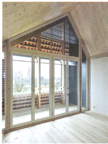
Die offene Konstruktion prägt Loggia und Innenraum.
