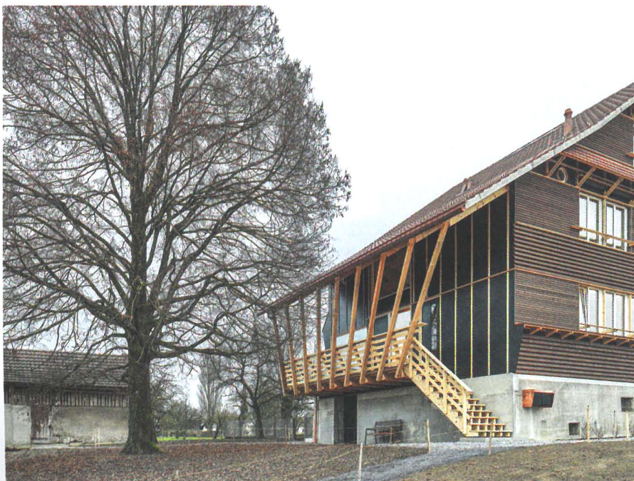
Beim Ersatzneubau in Cham dienen seitliche Lauben als Zugang – wie bei traditionellen Bauernhäusern.
