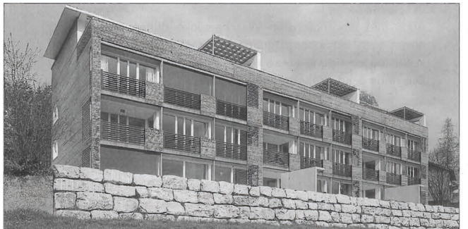
Moderne Ausstrahlung: Mehrfamilienhaus aus Holz in Zürich-Höngg
