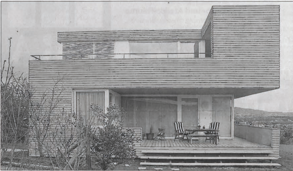
Hauswände im Werk vorproduziert: In Holzrahmen-Bauweise erstelltes Doppelfamilienhaus in Dietikon, aufgenommen aus drei Perspektiven
